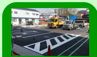
駐車場の整地やライン引きはK社の本業の一つであり、自社で施工されていました。
