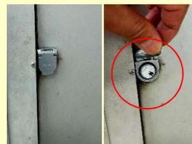
そこで前回設置時に、テンキーから独立した形で新たに解錠キーを使用できるように加工、設置しました。今回のVE-10を設置するに当たっても既存の加工部分を利用して、これまで同様、解錠キーを使用できるようにしました。(写真左)
