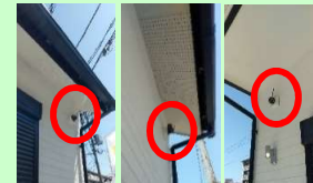
防犯カメラが敷地内を撮影
