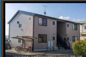
①建物の外観からスタート
