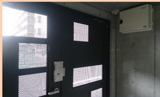
ゴミステーション内部
