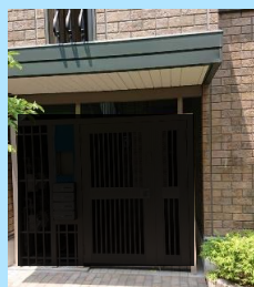
↑門扉設置前の開口部
