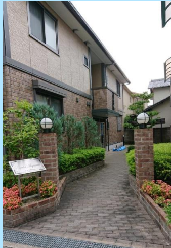
第一号の設置は大阪の物件です。
