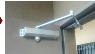
交換前と交換後のドアクローザー。こちらの物件の非常扉すべて11台分の交換を行いました。
