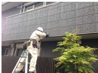
設置工事。配線工事も丁寧に行い3階のオーナー様宅へきれいに引込みました。
