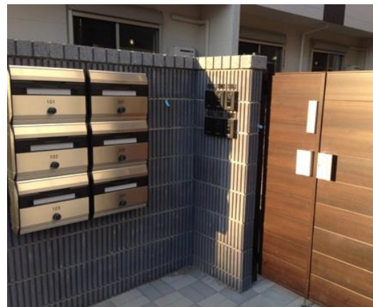
左: エントランス外側テンキー部 左下: エントランス内側本体部 ※防水対策の為ステンレスボックスを設置しています。
