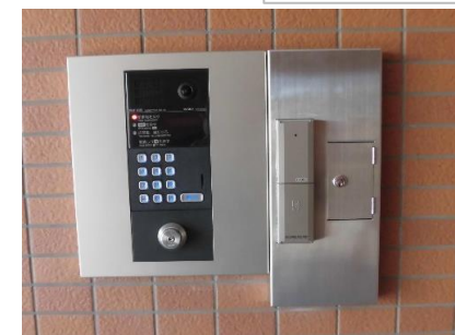
下: インターホン集合機に併設したVリーダー。 ステンレスのBOXはインターホンに合わせてオーダーメイド作成することも可能です。
