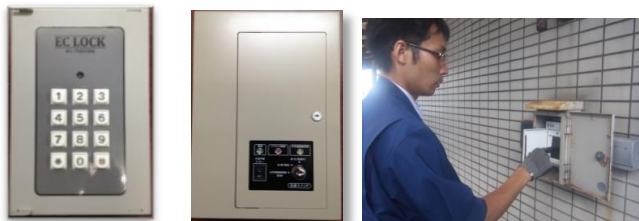
左: ECロックテンキー、中: ECロック制御装置、右: ECロック点検作業
