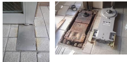
左: フローアヒンジ 右: 劣化した品と新しい品
