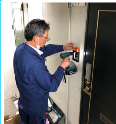
マイロック設置とインターホン交換の様子
