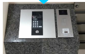
エントランス集合玄関機のリニューアルと「Vリーダー」の設置。
