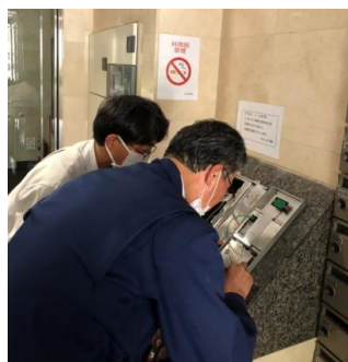
エントランス集合玄関機のリニューアルと「Vリーダー」の設置。
