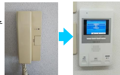
マイロック設置とインターホン交換の様子
